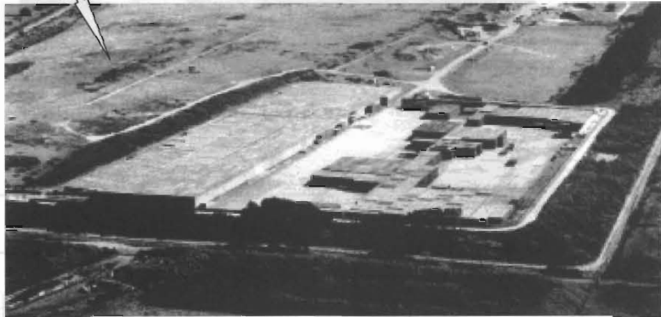
ドリッグ処分場全景
