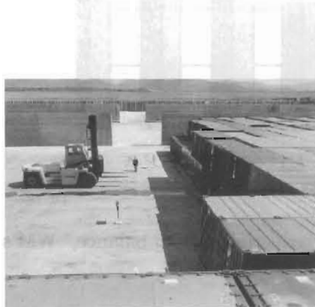
コンクリートボルト内での作業
